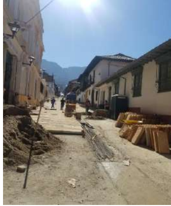
Imagen 13. Instalación piedra Barichara en las intersecciones de la calle 10 con carrera 5 y carrera 6
