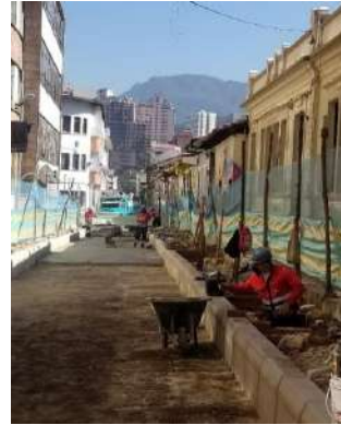
Imagen 14. Intervención de carrera 4 en el tramo de calle 12 a 12B
