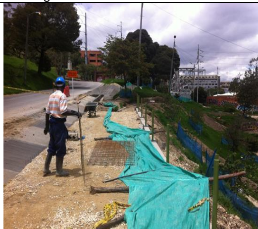
Foto 6. Foto 1. CÓDIGO 17-008 PARQUE ZONAL LA CONCORDIA Entre Carrera 1 Y Carrera 1 Este Con Calle 13b Y Calle 15. Se observa que la avenida pasa por el límite de la obra facilitando el cargue y descargue de material. Costado Norte Sur.
