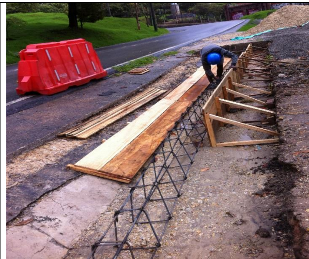
Foto 3. CÓDIGO 17-008 PARQUE ZONAL LA CONCORDIA Entre Carrera 1 Y Carrera 1 Este Con Calle 13b Y Calle 15. Se observa que la avenida pasa por el límite de la obra facilitando el cargue y descargue de material. Costado Oriental.
