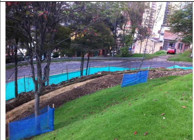
Foto 5. CÓDIGO 17-008 PARQUE ZONAL LA CONCORDIA Entre Carrera 1 Y Carrera 1 Este Con Calle 13b Y Calle 15. Se observa que la avenida pasa por el límite de la obra facilitando el cargue y descargue de material. Costado Oriental.
